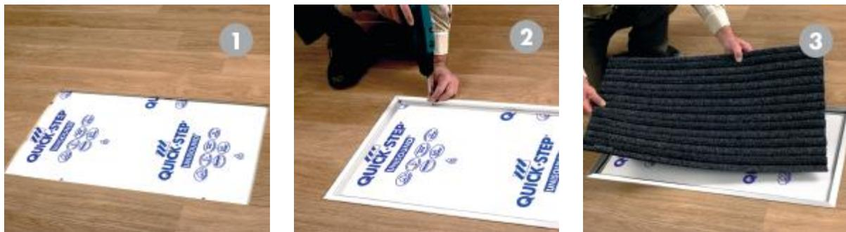
1. Verlegen Sie zuerst Ihren Boden (siehe Verlegeanweisungen für Quick-Step® Böden). Sägen Sie, falls erforderlich, die Bodenpaneele auf die korrekte Länge, sodass der vorgeformte Rahmen hineinpasst. Lassen Sie Platz für eine Dehnungsfuge, sodass sich Ihr Holzboden noch bewegen kann.
